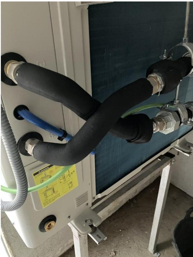
Se intercambiaron la tuberías para que la entrada a la máquina enfriadora se hiciese a través de la parte inferior del depósito, de esa manera evitamos cualquier posibilidad de aspirar aire e introducirlo en la máquina enfriadora.
