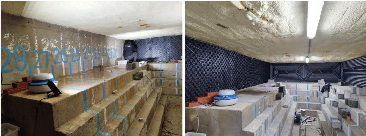
Una vez finalizada la instalación de los paneles radiantes, se incorporan al prototipo el sistema de humidificadores, encargados de mantener la humedad de la cámara por encima del 95%. La batería de humidificadores industriales están conectados al sistema de suministro de energía de la bomba geotérmica de forma que a través de los intercambiadores, el fluido suministrado de agua al humidificador puede estar previamente pretratado
