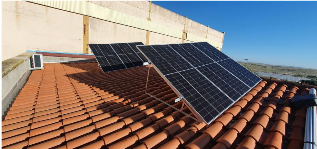
*Imagen paneles solares instalados en cubierta INTROMAC*
