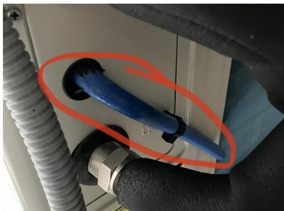
Finalmente, mediante la llave de llenado, se aumenta la presión de la instalación para forzar la apertura de la válvula de sobrepresión (marcado en rojo) de la enfriadora y tras varios ciclos, se consigue liberar todo el aire de la instalación.
