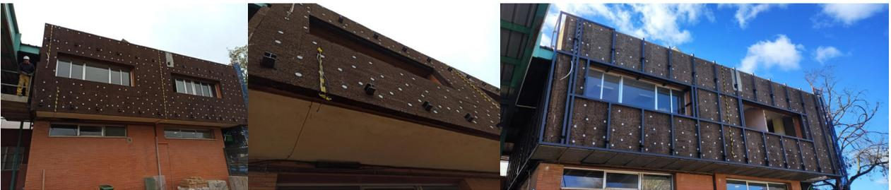
Tras estas actuaciones, se procede al montaje del jardín vertical mediante panel de placas rígidas extrusionadas de policloruro de vinilo expandido de 10 mm de espesor, con juntas selladas con masilla adhesiva-sellante monocomponente de poliuretano.
