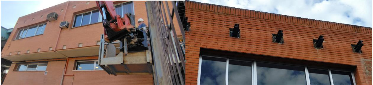
En primer lugar, se coloca el aislamiento térmico de doble capa de corcho expandido cogido con adhesivo y espigas, al muro fachada del edificio. Seguidamente, se procede a la instalación de la subestructura metálica de perfiles rectangulares cogidos a la estructura principal del edificio, forjado de suelo y techo de la planta afectada.
