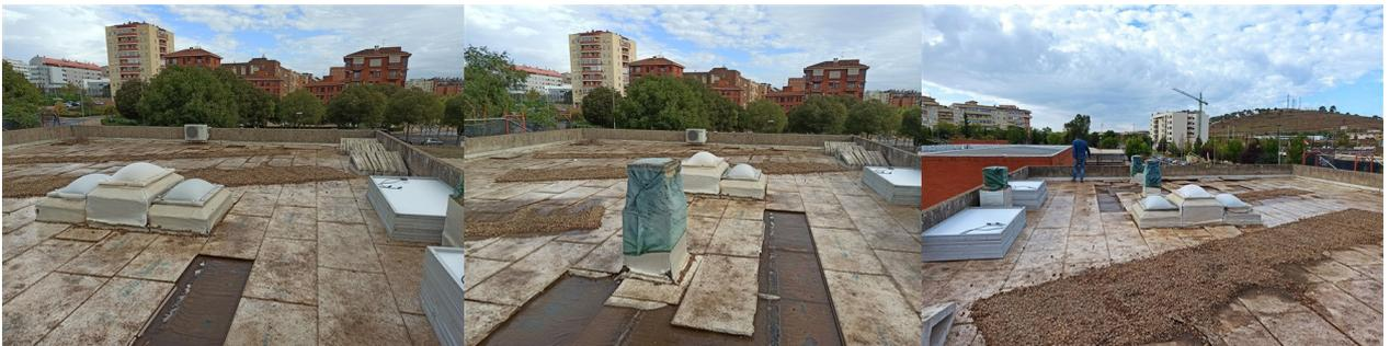
Sobre éste se coloca el corcho expandido en doble capa para llegar al espesor deseado. Para la impermeabilización se instala lámina flotante de PVC soldada en las uniones y perímetro.
