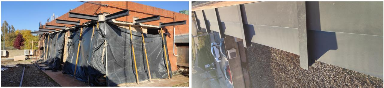
Para la protección del presente cerramiento, se proyecta sobre él un sistema de protección metálica, anclado a la estructura existente mediante perfiles laminados y lacados. Dicha celosía es corredera para evitar la proyección de sombra sobre el vidrio en los meses de captura de calor, meses fríos del año.
